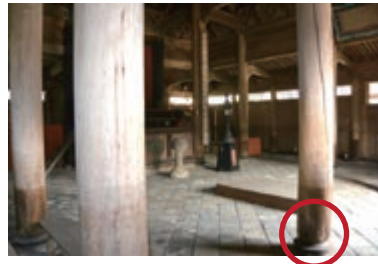
功山寺仏殿の木製礎盤
