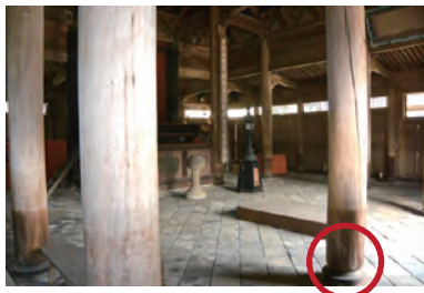
功山寺仏殿の木製礎盤
