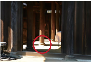
正福寺地藏堂の木製礎盤
