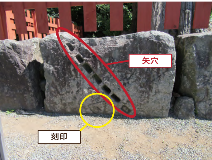
上宮前面の石垣に見られる矢穴と刻印 (鶴岡八幡宮)
